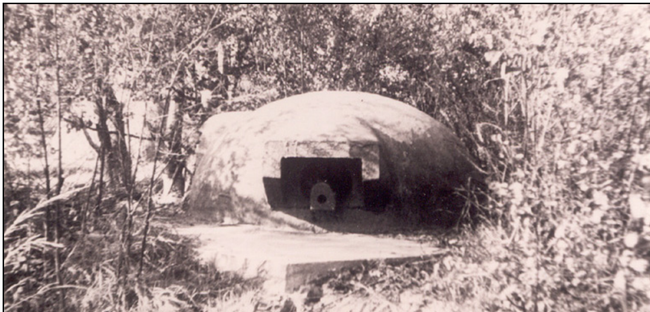
Afbeelding van een kazemat met gietstalen koepel voor zware mitrailleur
